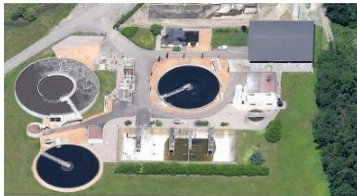
Station d'épuration de Pont du Château.
